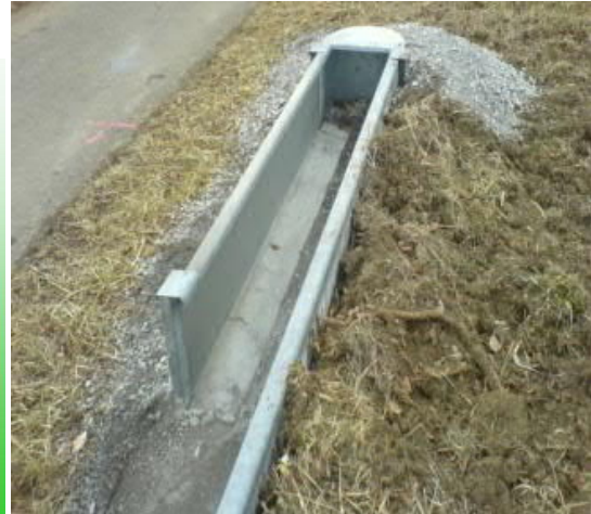
Figur 2 1 . Vänstra bilden exempel på grodmur/ledarm med överhäng. Högra exempel på avslut av grodmur/ledarm som leder tillbaka grodorna.
