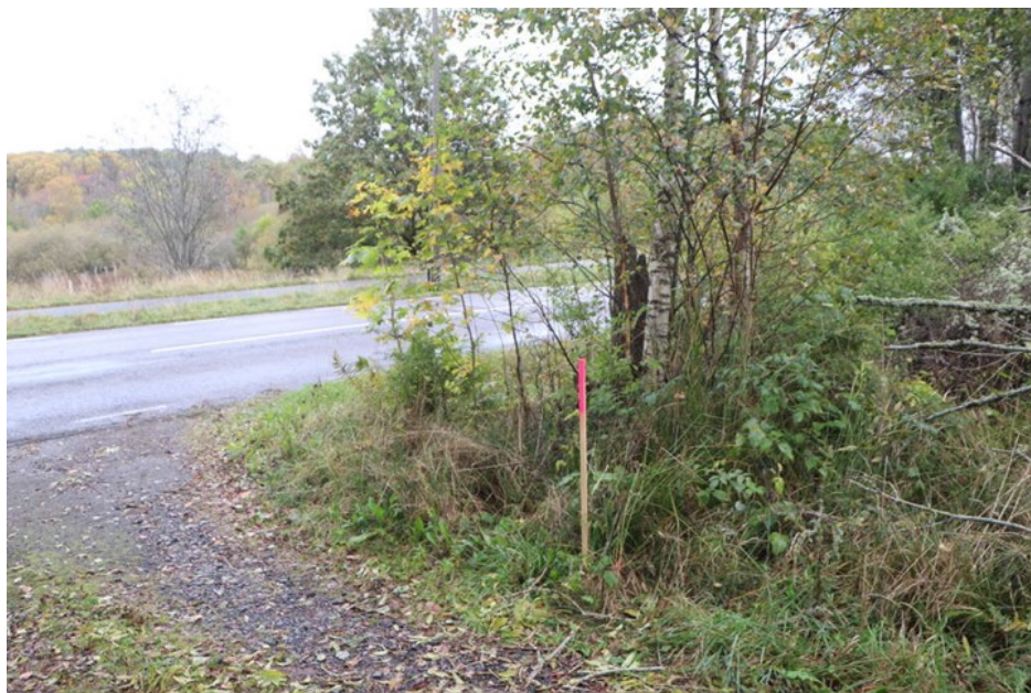
Foto A. Utstakning med käppar. Foto från Trafikverket.
